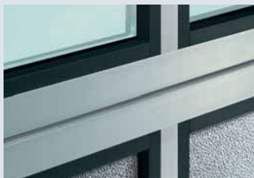
Pohled na vnitřní stranu vrat s černými zasklívacími lištami
